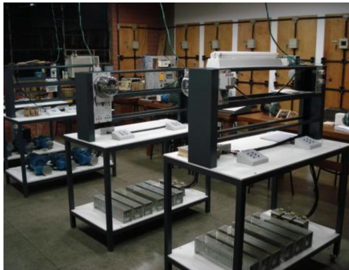
Figura 7 - Bancadas de Motores e Acionamentos Elétricos
