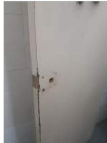
FOTO 04: Porta da cabine sanitária sem fechadura.
