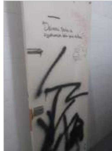
FOTO 04: Porta da cabine sanitária sem fechadura e com pichações.
