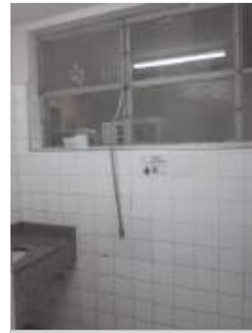
FOTO 04: Janela basculante em ferro e pintura na cor cinza claro.
