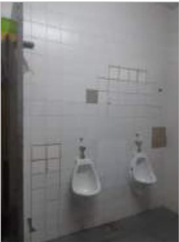
FOTO 05: Parede de instalação dos mictórios com trechos sem revestimento.
