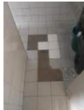
FOTO 10: Piso com trechos sem revestimento.
