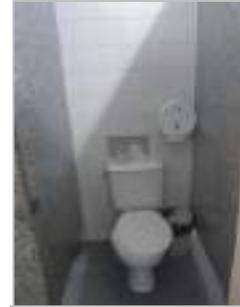
FOTO 08: Cabine sanitária 02, com trecho sem revestimento na parede.
