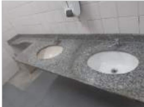
FOTO 04: Bancada em granito com trecho quebrado.
