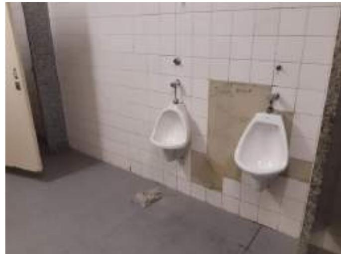
FOTO 04: Mictórios e parede sem trecho de revestimento cerâmico.
